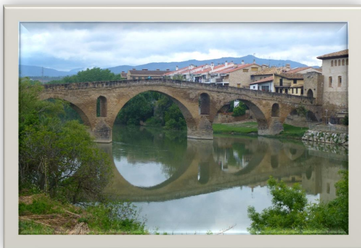
Image: Puente La Reina Bridge
