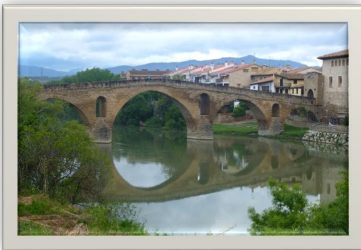
Image: Puente La Reina Bridge
